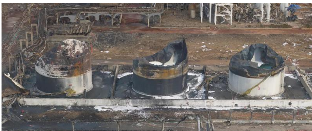
图 9 天嘉宜公司受爆炸冲击起火燃烧后的苯和甲醇储罐
