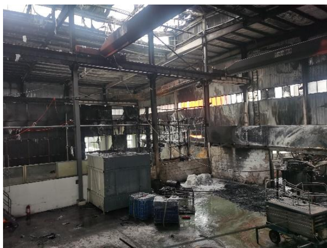
图 3 火灾事故现场情况
